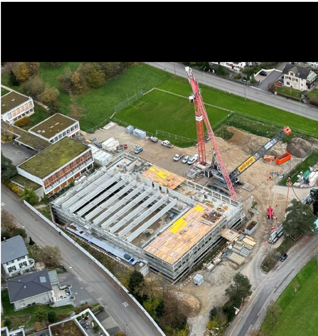
Neubau Oberstufenzentrum OSZ A Zofingen | Realisierung 2023 – 2027 | Bausumme 43.6 Mio
